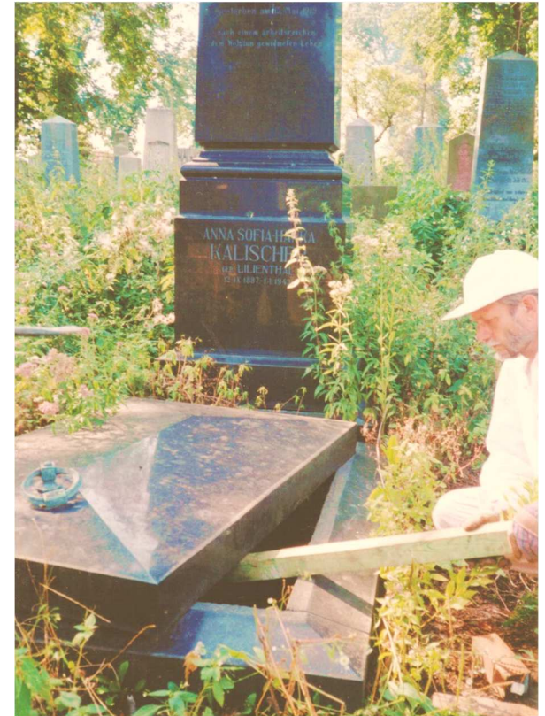
Een verschoven deksteen wordt weer teruggeplaatst
